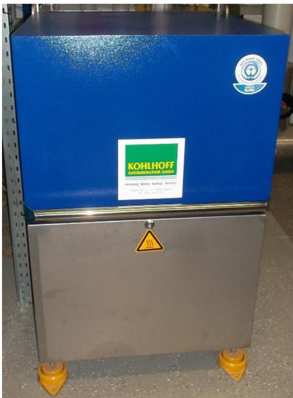
Frontansicht Blockheizkraftwerk - EC Power
