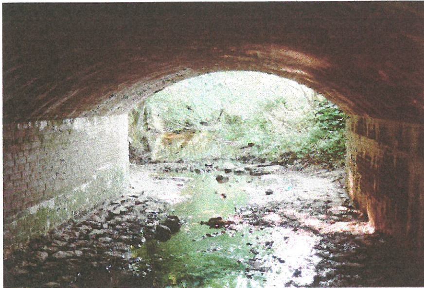
Geräumige, ökologisch gut gestaltete Straßenunterführung der Barnitz unter der „L 88“ Richtung Schulenburg
